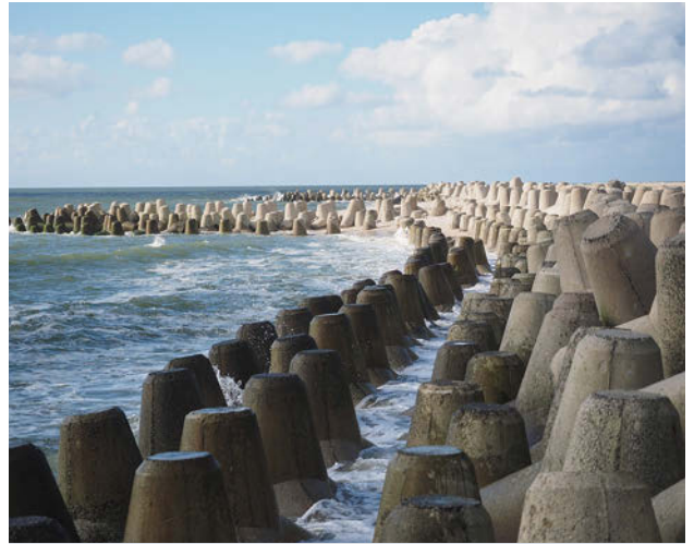
tetrapod [ˈtɛtrəˌpɒd] (n.) 消波塊能吸收並減弱海浪的衝擊，保護海岸不受侵蝕。
